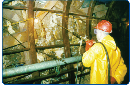
Tünelde Poliüretan uygulaması
